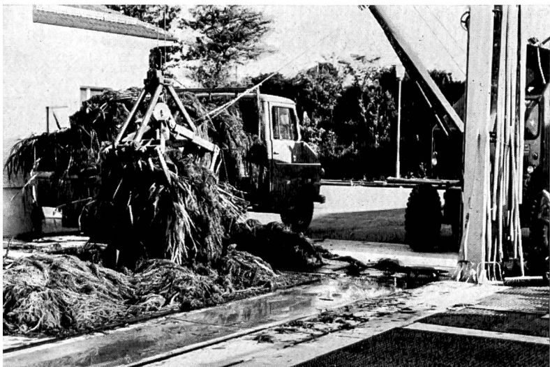
Bild 4 Entfernen von anfallendem Algenmaterial zur Kompostierung beim Kraftwerk Reckingen
