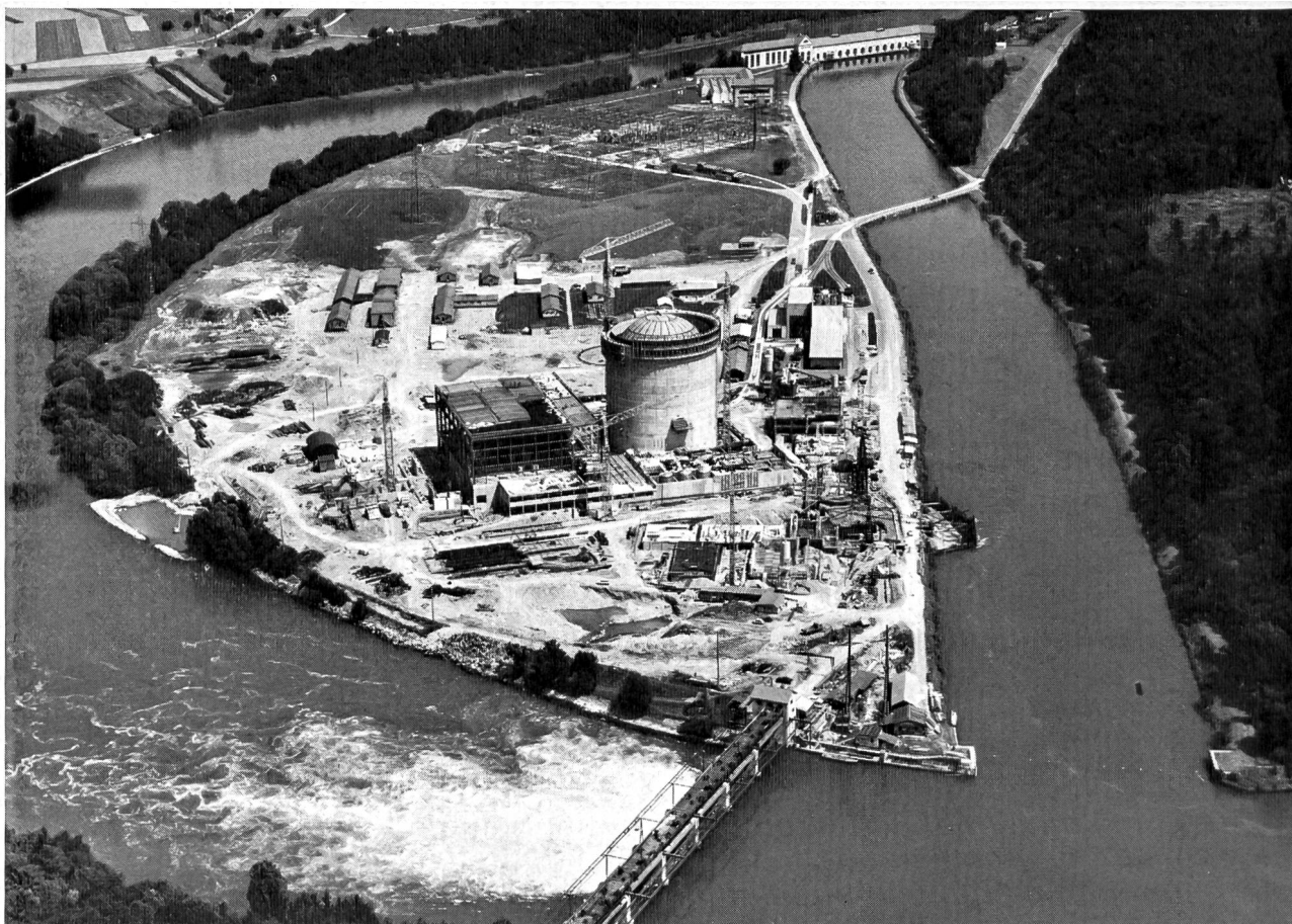
Bild 1 Uebersicht über die Atomkraftwerkanlage Beznau auf der von der Aare umflossenen Insel; im Vordergrund Stauwehr, rechts Oberwassereinlaufwerk zu der im Hintergrund sichtbaren Wasserkraftanlage Beznau. Rechts vom 50 m hohen Reaktorgebäude wird am Kühlwassereinlaufwerk gearbeitet. Flugaufnahme Comet vom Juli 1967.
