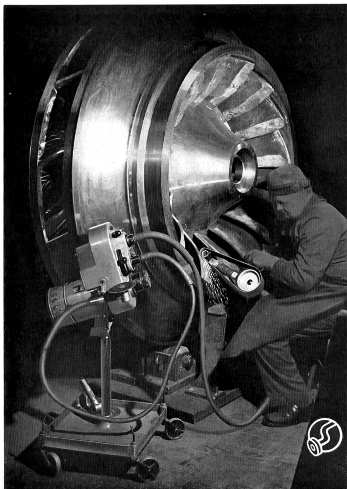
Essais d'atelier du répartiteur de la Centrale de Bitsch — Pression: 143 atm.
