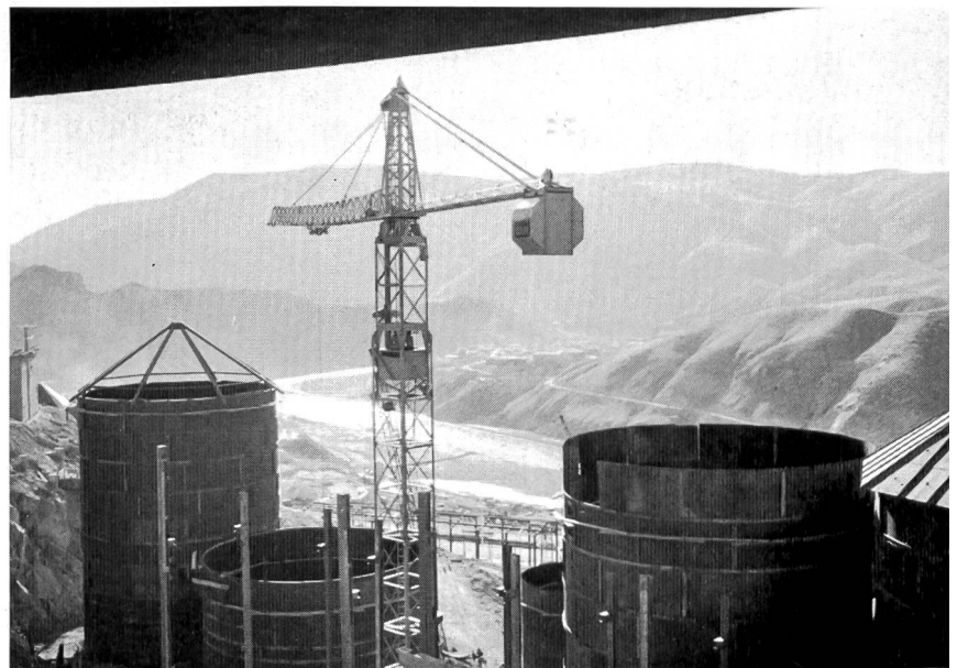
Bild 49 (unten) Aufbau der Betonieranlage Keban mit Blick auf den Euphrat.
