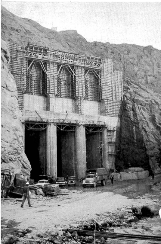
Bild 45 (oben) Einlaufbauwerk für einen der beiden Umleitungsstollen und Grundablässe für die Talsperre Keban.
