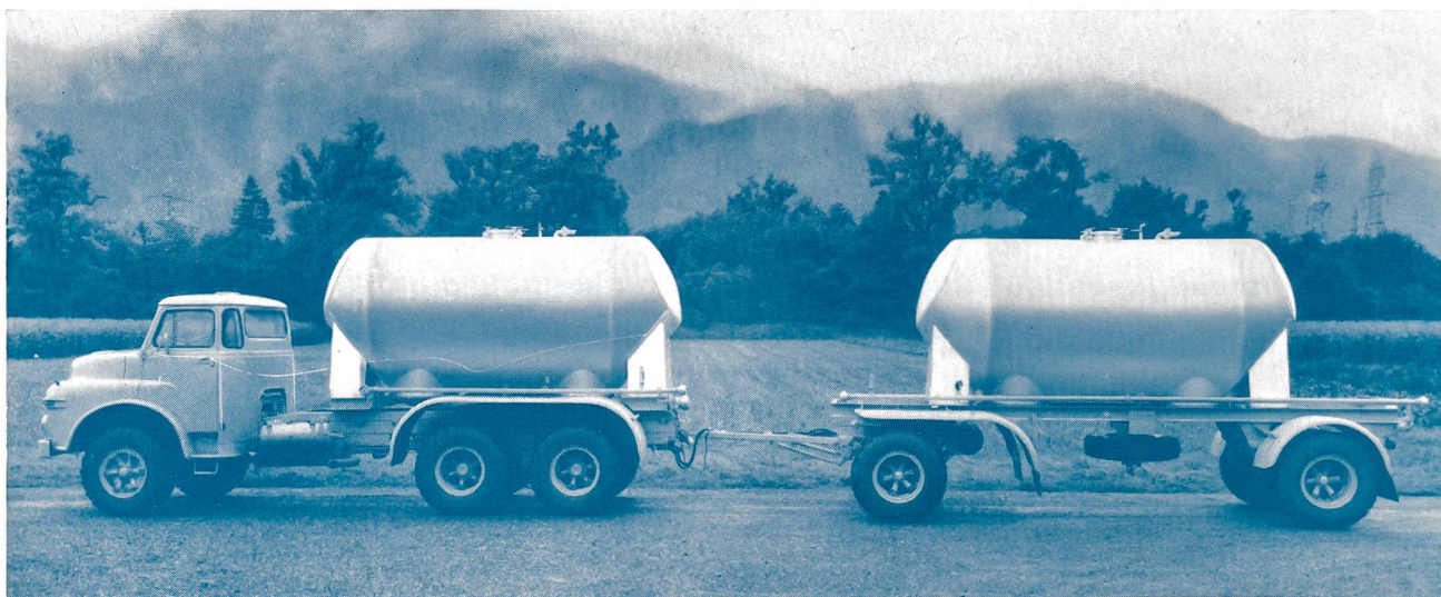
STAG-Anhängezug auf 5 Achsen. Spezialkonstruktion für die Türkei. 36 t Gesamtgewicht, 24 t Nutzlast, 2 Aluminiumbehälter. Einsatzort: Keban-Damm, Türkei.
