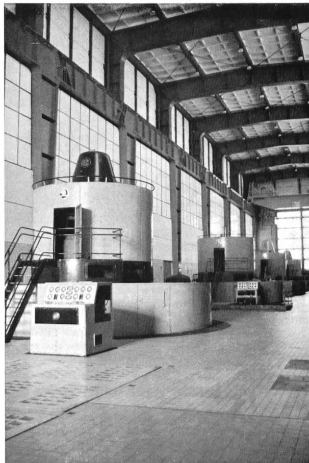
Bild 12 Zentrale Orlik am Talsperrenfuss.
