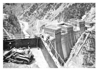
Bild 15 Betoneinbau bei der Bogentalsperre Punt dal Gall; Blick talaufwärts in das Spöltal.
