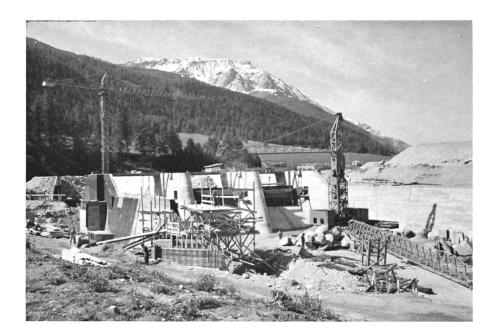
Bild 11 Wasserfassung am Inn unterhalb S-chanf für die Kraftwerkstufe S-chanf — Ova Spin — Pradella
