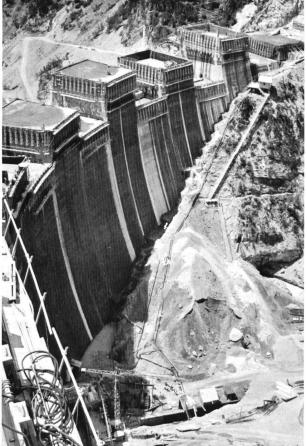
Bild 16 Verteiler und Rüttler beim Einbau des Betons für die Talsperre Punt dal Gall.
