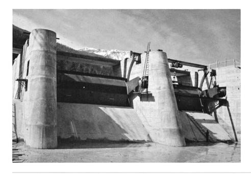
Bild 12 Montage der Stauwehrschützen für die Innwasserfassung.
