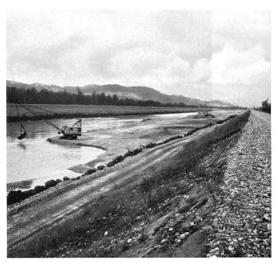
Bild 30 Ausbeutung einer Kiesbank in der st. gallisch-liechtensteinischen Rheinstrecke; im Hintergrund das Werk Salez der Rheinkies AG. Der wasserseitige Fuss des Rheindammes ist gegen Unterspülung geschützt durch einen 5 m breiten Blockwurf, welcher durch ständige Nachschüttung der sich absenkenden Sohle angepasst wird. Ueber dem Blockwurf ist eine dem Unterhalt dienende Fahrstrasse angelegt; die Böschung des Hochdammes ist mit groben Steinen gepflästert.
