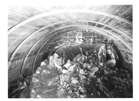
Bild 8 Kernausbruch; im Hintergrund Schalung für den Gewölbescheitel.
