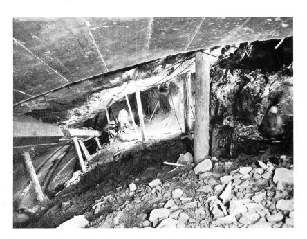
Bild 7 Ausbruch der Scheitelpartie; links Gewölbeschenkel; oben fertig betonierter Gewölbering.
