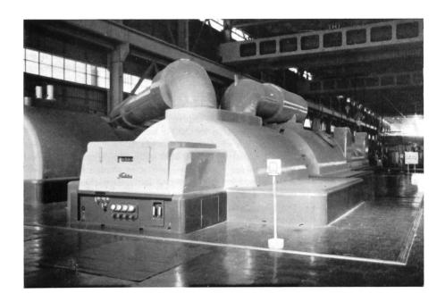
Bild 3 Einer der vier Zweiwellen-Turbosätze von 265 MW im Kraftwerk Goi.
