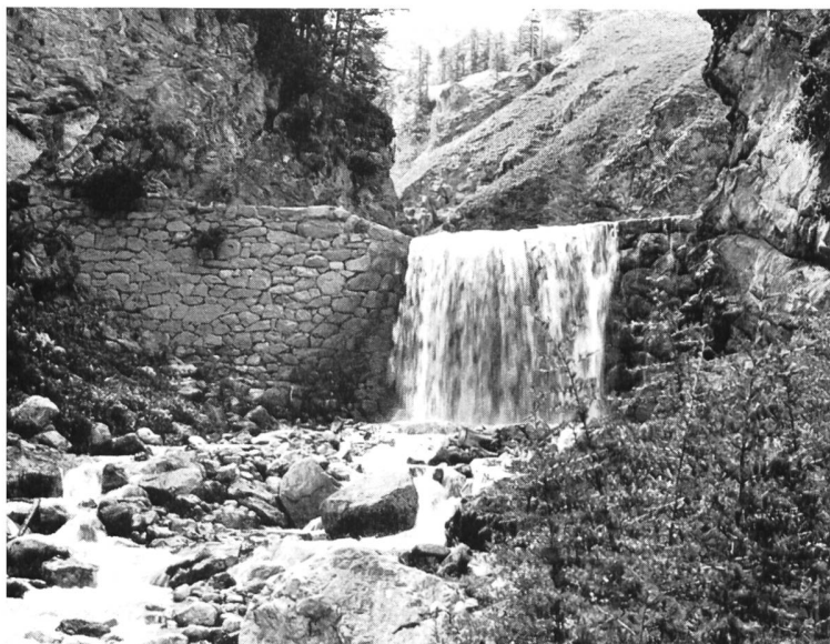
Bild 26 Eine der zahlreichen Schutzsperren zur Sohlenfixierung des wilden Rosegbaches.
