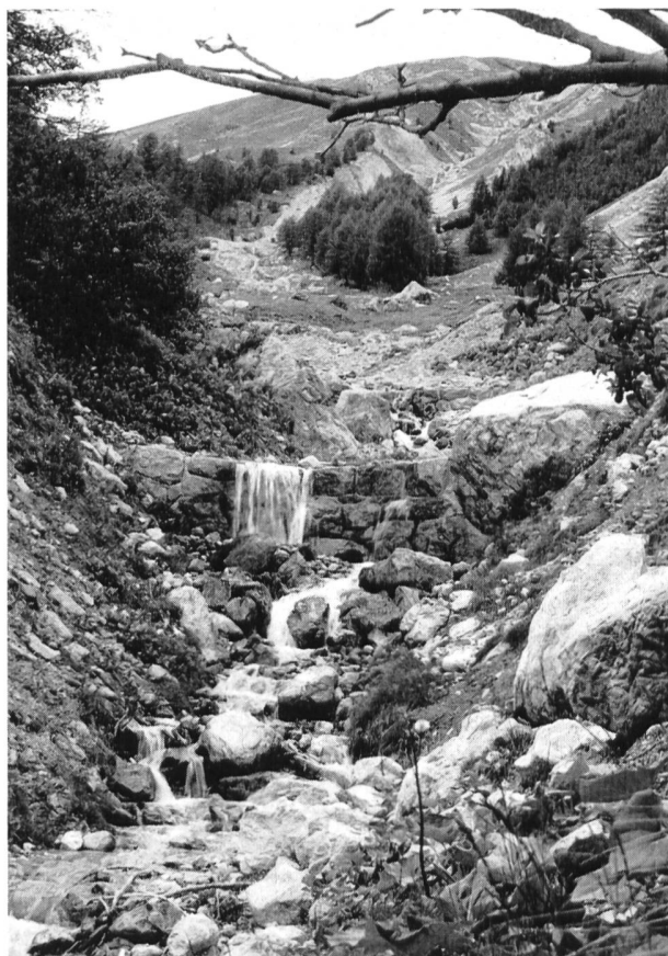
Bilder 24 und 25 Hochwassersperren in Trockenmauerwerk in Val Zuondra ob Celerina. Dieses stark erodierte Wildbachtobel — ein Seitental des vom Schlattainbach durchflossenen Val Saluver — stellt eine stete Bedrohung des stattlichen Dorfes Schlarigna/Celerina dar; nach den Verheerungen von 1944 wurden wieder kostspielige Verbauungen im Unterlauf des Schlattainbaches durchgeführt.
