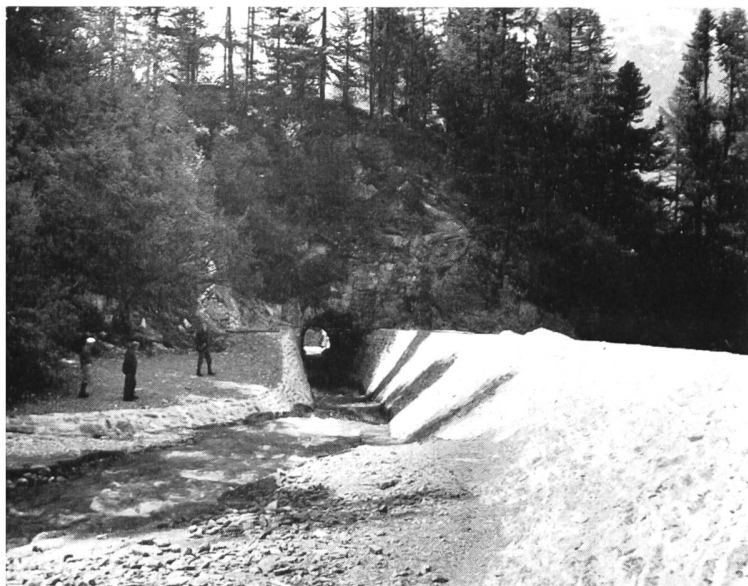
Bild 23 Umleitung des Surlejbaches durch einen Felsstollen und Abfluss in den Silvaplanersee zum Schutze des früheren Weilers Surlej.
