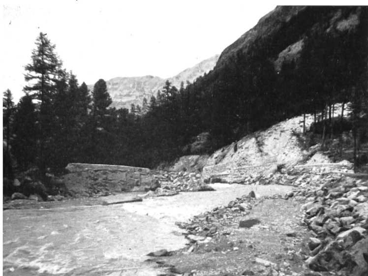
Bild 26 Eine der zahlreichen Schutzsperren zur Sohlenfixierung des wilden Rosegbaches.
