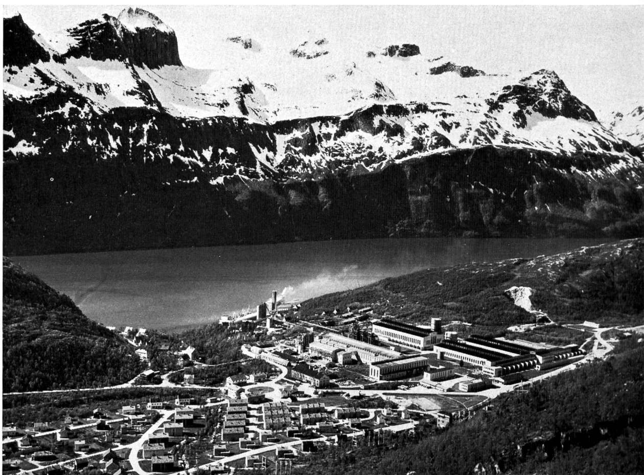
Bild 1 Glomfjord Salpeterfabrik (ein Werk der Norsk Hydro), etwas nördlich des Polarkreises gelegen.
