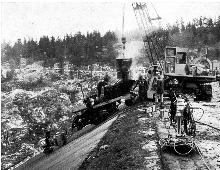
Bilder 7 und 8 Venemo Staudamm mit Asphaltdecke; Nutzinhalt des Staubeckens 22,9 Mio m 3 , max. Staukote 703 m ü.M., max. Absenkung 666 m ü.M.
