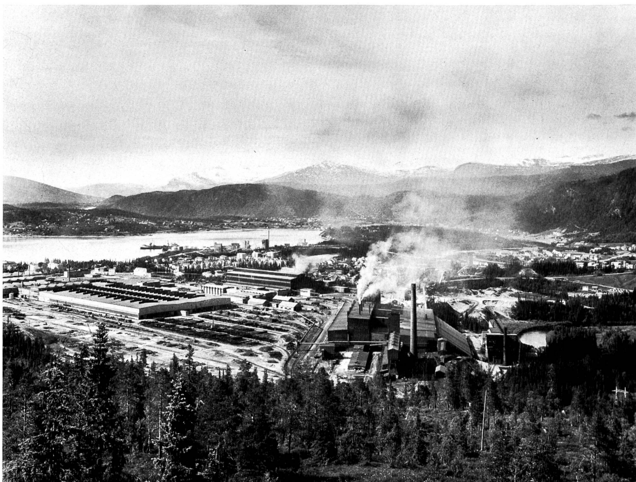
Bild 12 Die Anlagen des «Norsk Jernverk» in Mo. Im Vordergrund das Roheisenwerk. Links das Stahlwerk und das Walzwerk. Im Hintergrund am Fjord Norsk Koksverk.
