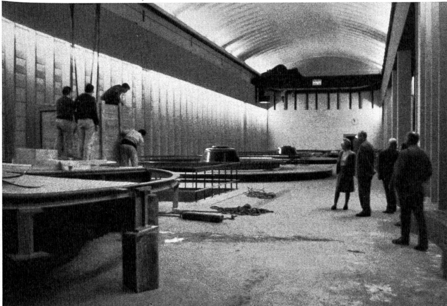
Bild 46 Inneres der Kavernenzentrale Bemposta der Hidro-Elctrica do Douro.
