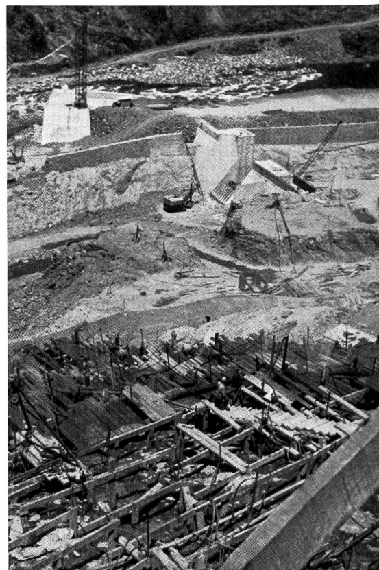
Bild 124 Injektionsarbeiten für die grosse Pfeilerstaumauer Alcántara.
