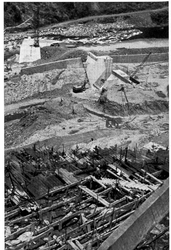
Bild 124 Injektionsarbeiten für die grosse Pfeilerstaumauer Alcántara.
