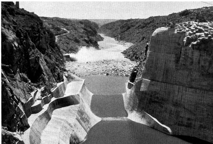
Bild 35 Unterhalb des Stauwehrs für das Kraftwerk Ricobayo am Rio Esla wurden wegen aussergewöhnlicher Felserosion anlässlich eines Hochwassers umfangreiche und kostspielige Verbauungen notwendig.
