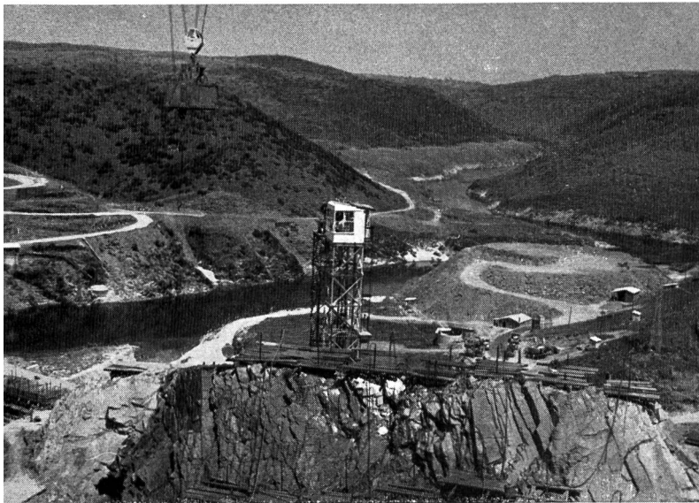
Bild 120 Das Tajotal unmittelbar oberhalb der Sperrstelle Alcántara.
