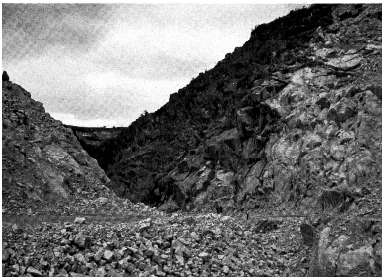
Bild 23 Felsaushub für die 200 m hohe Bogenstaumauer Almendra der Iberduero S. A.
