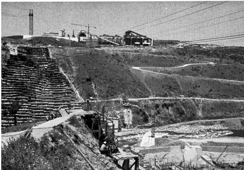
Bilder 121 und 122 Baustelle Alcántara; Blick auf die rechte (oben) und auf die linke (unten) Talflanke des Tajo mit Installationen für die sehr umfangreichen Injektions- und Konsolidierungsarbeiten zur Fundierung der Talsperre und für die anschliessenden Betonierungsarbeiten.
