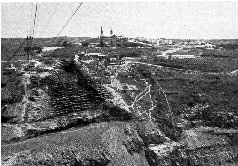
Bilder 121 und 122 Baustelle Alcántara; Blick auf die rechte (oben) und auf die linke (unten) Talflanke des Tajo mit Installationen für die sehr umfangreichen Injektions- und Konsolidierungsarbeiten zur Fundierung der Talsperre und für die anschliessenden Betonierungsarbeiten.
