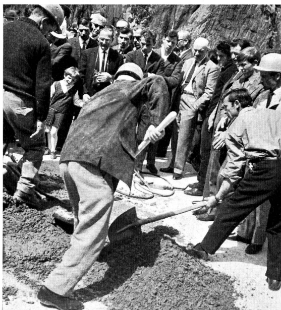
Bild 4 Einbringen des letzten Betons auf der Staumauer Curnera am 11. August 1966.
