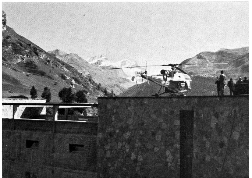
Bild 13 Helikopter auf dem Dach des Kommandoraumes der Pumpzentrale Z'Mutt.
