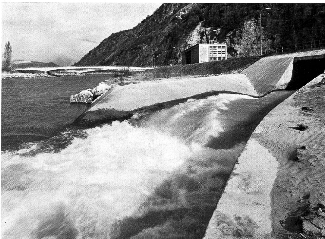
Bild 9 Zentrale Nendaz im Rhonetal und Wasserrückgabe in die Rhone.
