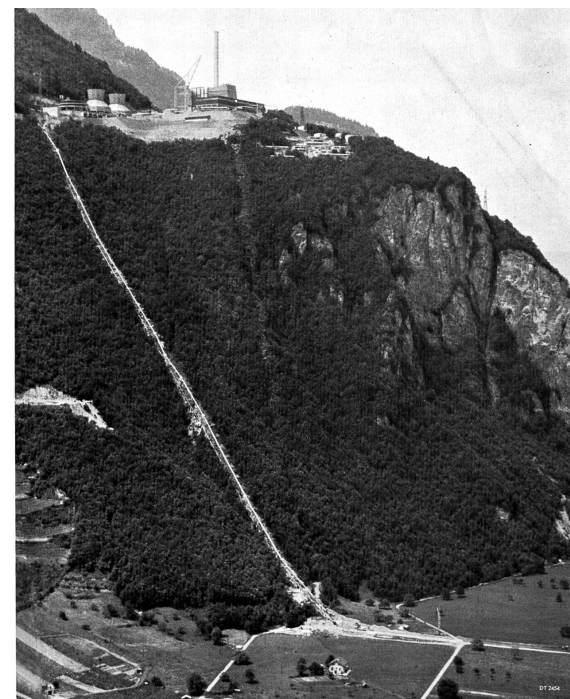
Fig. 3 — Vue aérienne de la centrale de Vouvry, montrant sa position surélevée à environ 450 m au-dessus du fond de la vallée, choisie pour éviter tout danger de pollution de l'air. Le combustible provenant de la raffinerie voisine y est chauffé à 120 °C pour être pompé, ainsi que l'eau d'appoint, de la vallée à la centrale.
