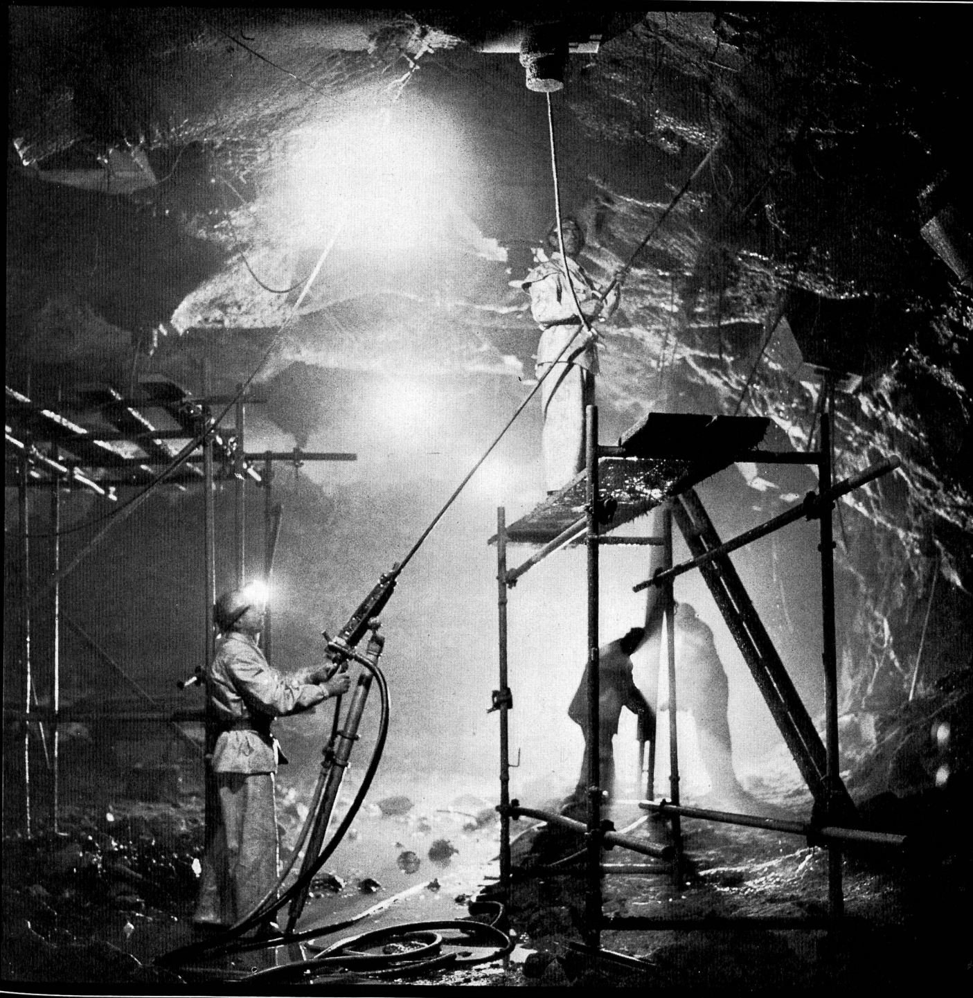
Sicherung der Kaverne Veytaux mit VSL Felsankern und VSL Felsnägeln. Ausführung: Précontrainte SA Lausanne
