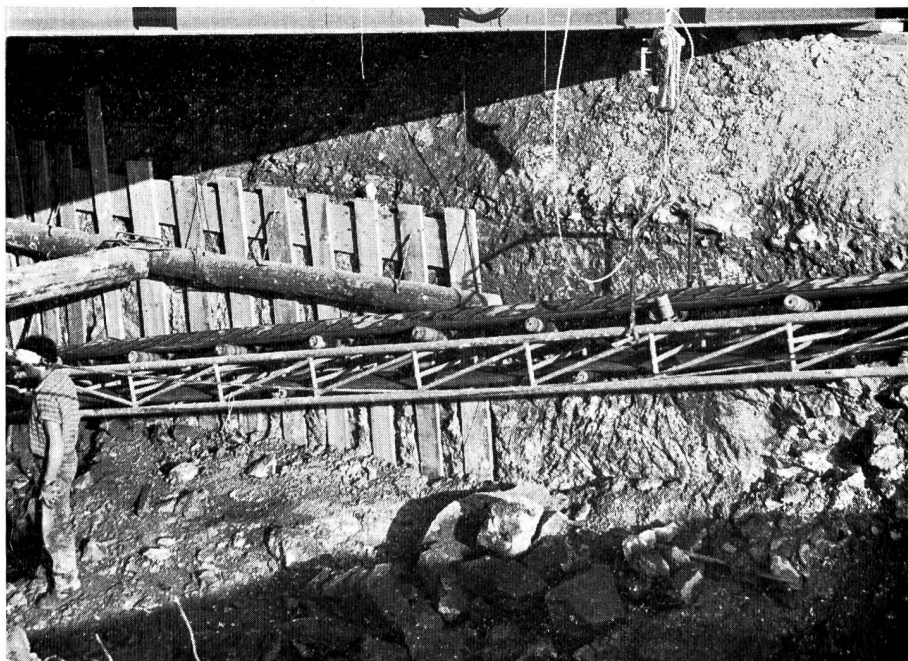
Fig. 7 Centrale de Veytaux. Passage du canal de fuite sous les voies du chemin de fer. Effet des injections de coulis de bentonite suivies d'injections de ciment, dans les remblais et la moraine. (Photo Jean Charpié, Lausanne)
