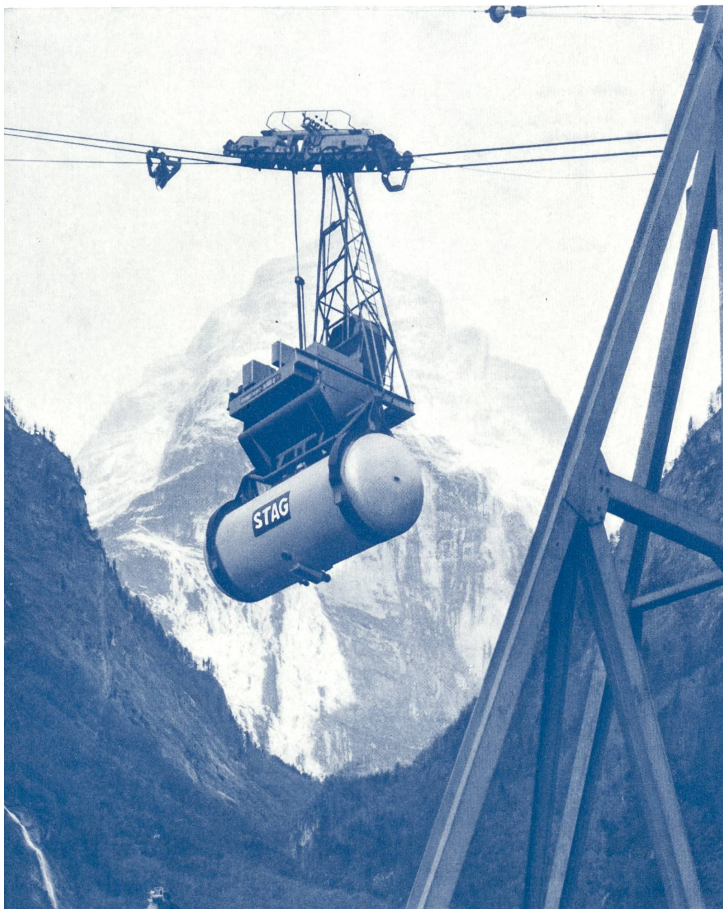
Aluminium-Behälter STAG an der Schweiseilbahn der KW Linth-Limmern, Fassungsvermögen 16 t Zement
