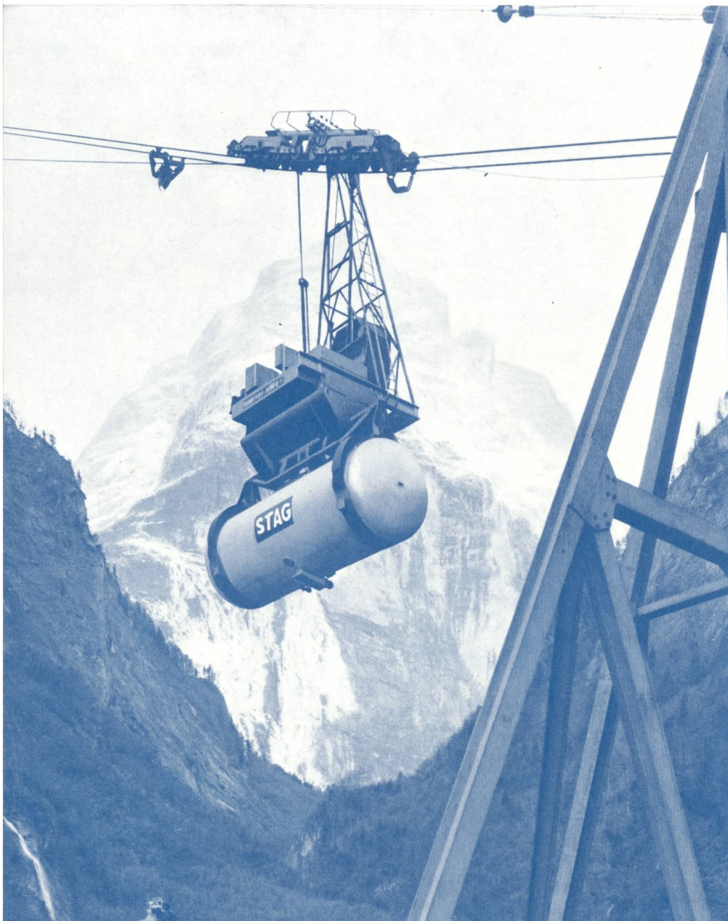
Aluminium-Behälter STAG an der Schwerseilbahn der KW Linth-Limmern, Fassungsvermögen 16 t Zement
