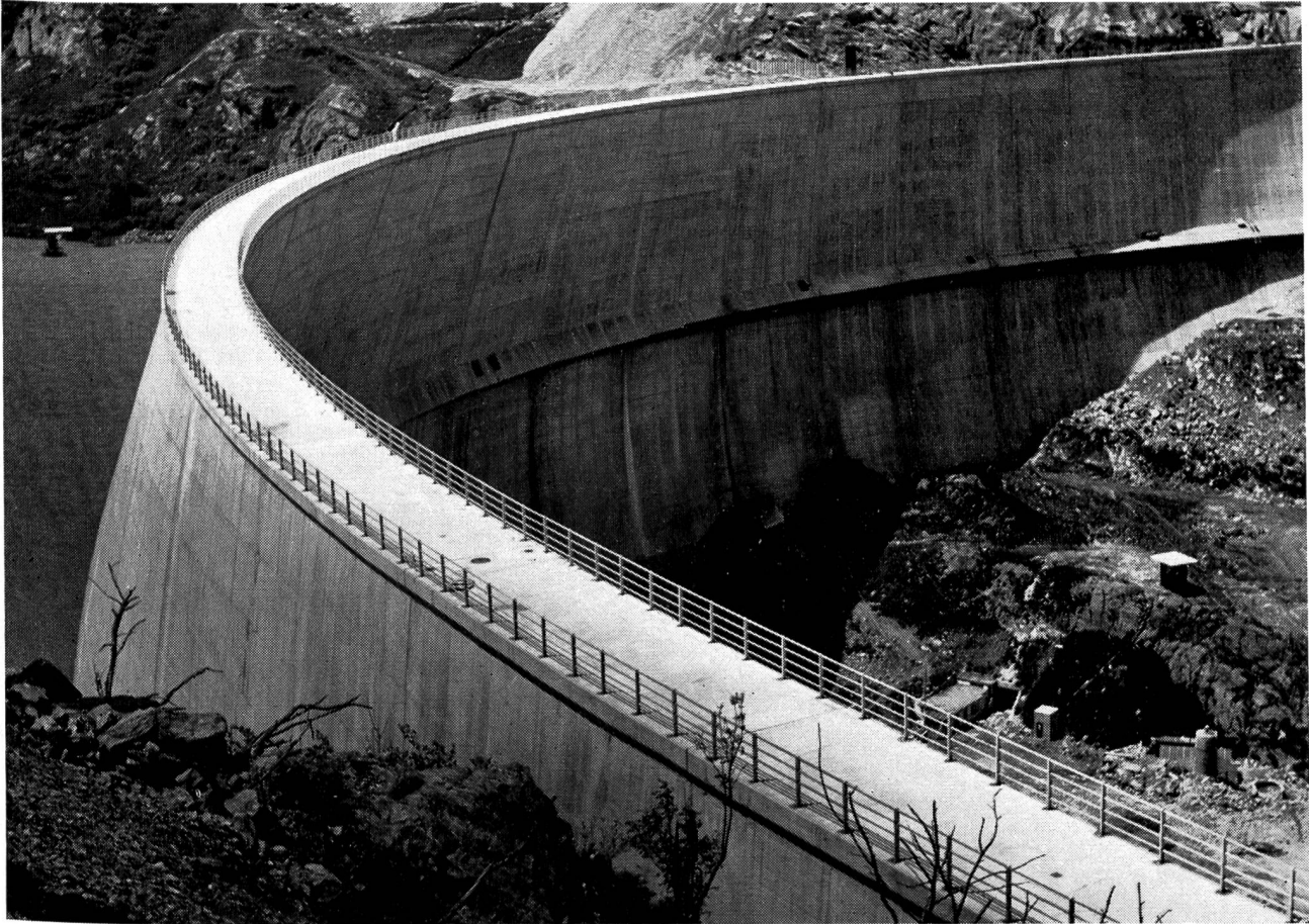
Bogenstaumauer Les Toules
