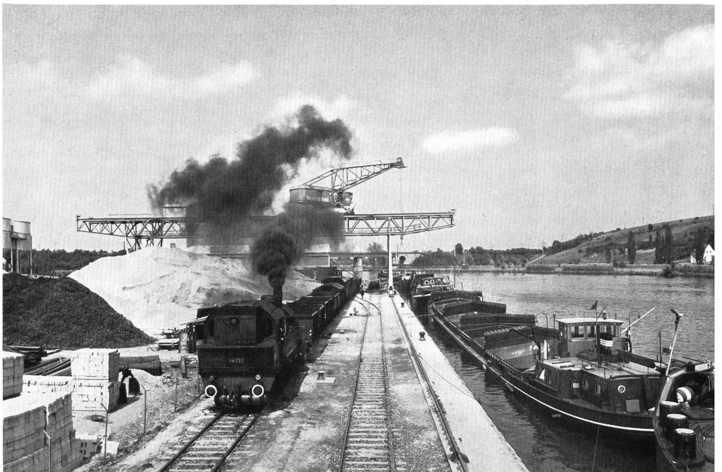
Bild 32 Lände Kitzingen am Main mit Geleiseanschluss für den Güterumschlag.
