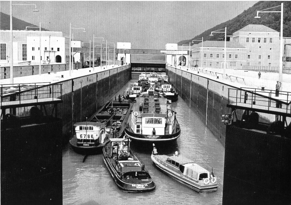
Bild 16 Regler Schiffverkehr in der Nordschleuse der internationalen Staustufe Jochenstein an der Donau unterhalb Passau.
