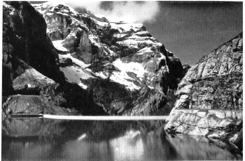
Bild 2 (links) Blick auf die 145 m hohe Gewölbesperre Limmernboden.
