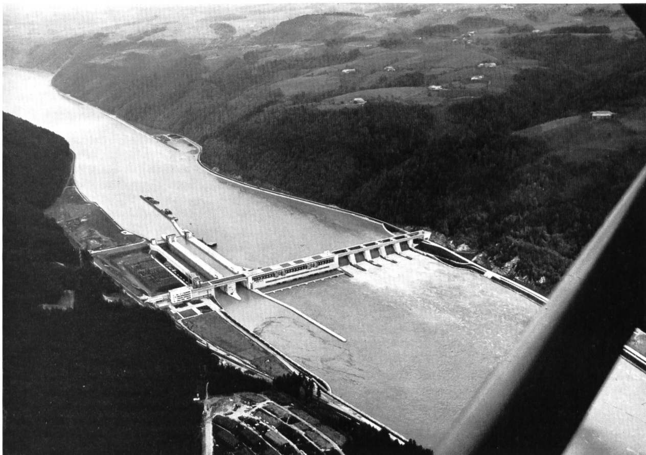
Bild 4 Die Kraftwerkstufe Aschach an der österreichischen Donau, die 1964 fertiggestellt wurde und das grösste Laufkraftwerk Mitteleuropas ist (Energieproduktion pro Jahr 1560 GWh).
