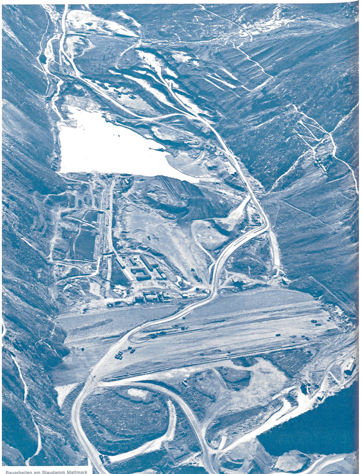
Bauarbeiten am Staudamm Mattmark
