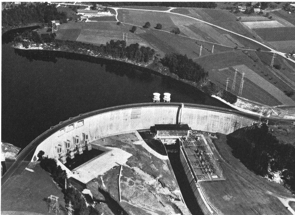
Staumauer und Stausee Schiffenen an der Saane; Kraftwerk und Schaltanlage am Fuss der Talsperre (Photo J. Mülhauser Fribourg)
