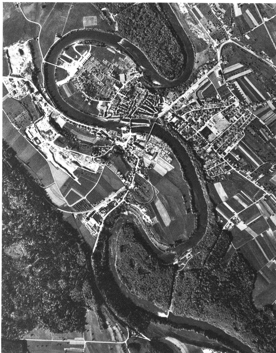
Fig. 3 Reuss bei Bremgarten. Am unteren Bildrand ist in der Reuss das Stauwehr des bestehenden Kraftwerkes Zufikon erkennbar. Unter der von dort in Richtung Bremgarten verlaufenden Waldschneise liegt der Wasserzuleitungsstollen zum ebenfalls erkennbaren Maschinenhaus. Die Staustelle des neuen Werkes (Fig. 4) ist etwas weiter flussabwärts, am Anfang der geraden Reussstrecke vorgesehen.
