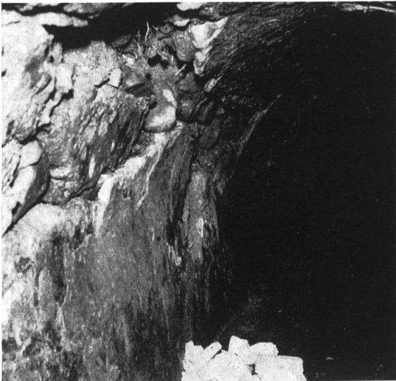
Der Stollen vor der Behandlung mit «Cital-Aquapaint»
