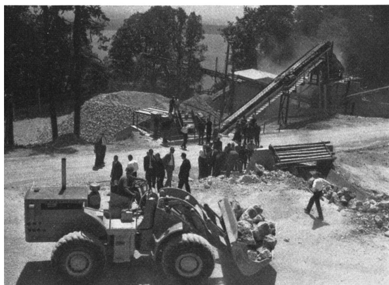
Fig.3 Aufbereitung des Steinmaterials für die Ufer- und Sohlensicherung des Nidau-Bürenkanals im Steinbruch Burgfluh
