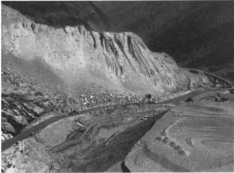
Fig. 14 Unterer Teil der grossen Allalin-Nordmoräne, die für den Dammbau abgetragen wird.
