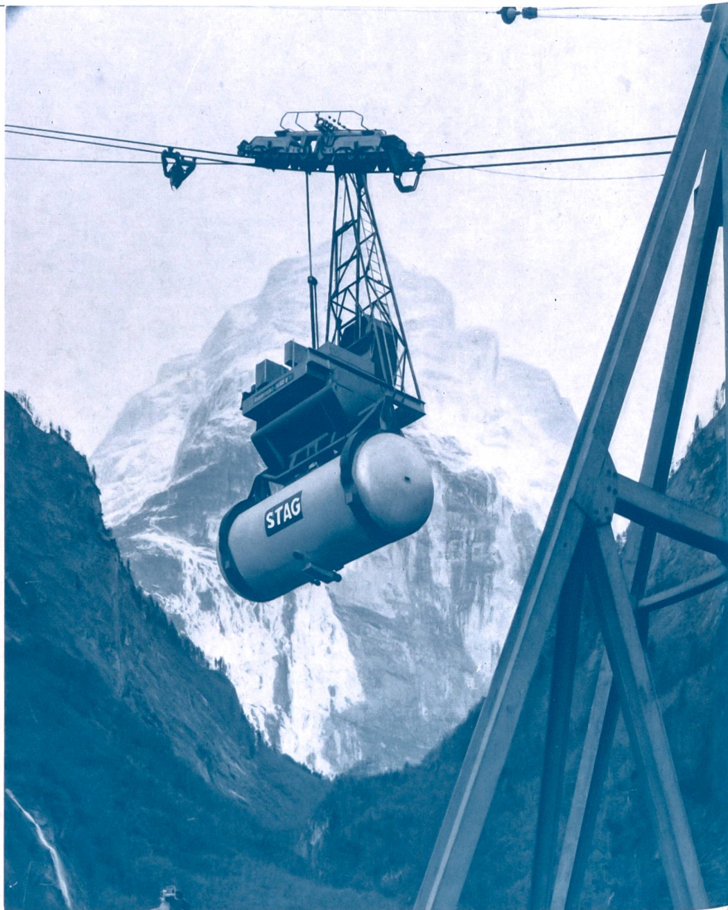
Aluminium-Behälter STAG an der Schwerseilbahn der KW Linth-Limmern, Fassungsvermögen 16 t Zement
