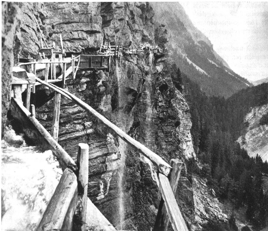
Fig. 4 Bisse suspendu, avec passerelle et chéneau, pour gros débit. Le bisse du Torrent-Neuf, à Savièse, accroché depuis le 16 e siècle à la paroi des Branlères.
