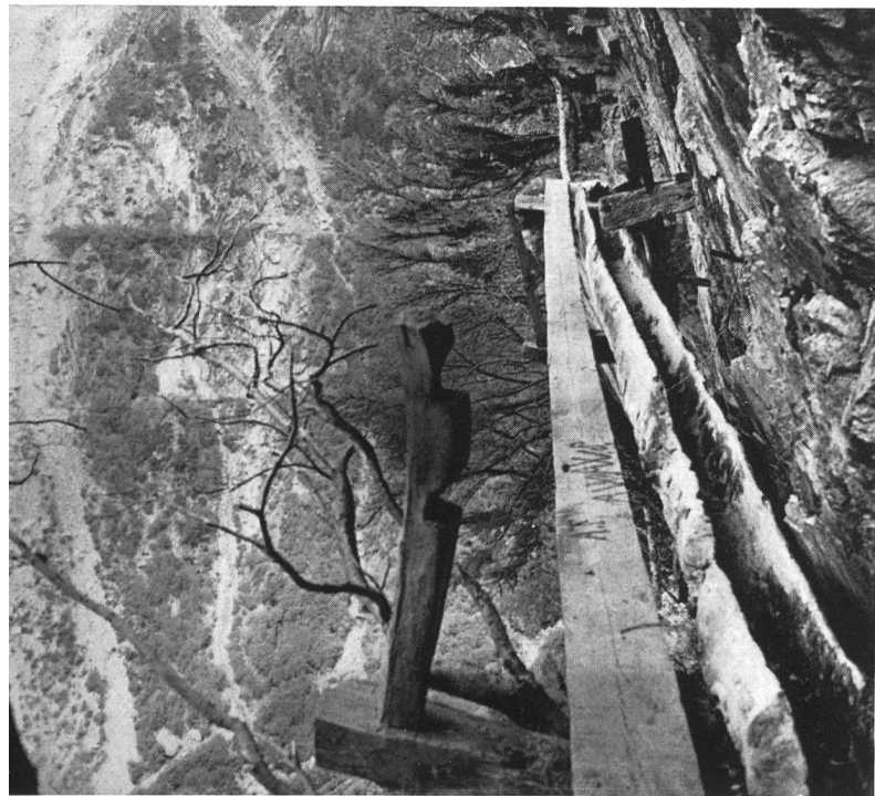
Fig. 3 Le bisse «Eggere» dans le Baltschiedertal. Cette conduite d'eau a été construite au 16e siècle et se compose par endroits de troncs de mélèzes évidés. La passerelle — simple planche posée sur les supports de la conduite — est indispensable pour le passage du garde-bisse au-dessus de l'abîme.
