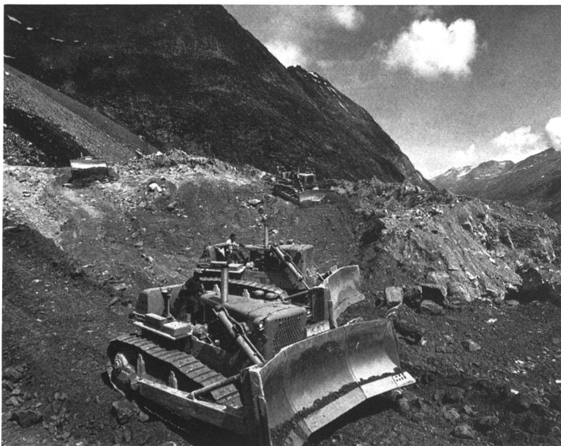
Fig. 8 Bulldozer auf der Nord-Moräne beschicken einen Kolman-Bandlader
