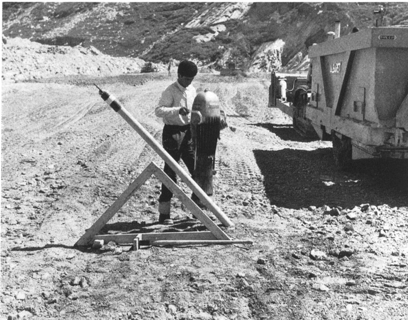
Fig. 13 Das Kernmaterial wird um einen geeigneten Setzungspegel mit einem Frosch verdichtet, rechts die 80 t-Pneuwalze
