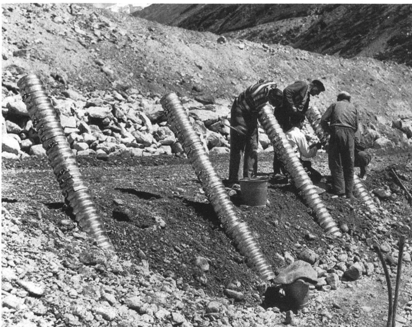
Fig. 14 Die Leitungen zwischen den im Dammkörper verlegten Messapparaten und der Messkammer werden in Armco-Rohren verlegt.
