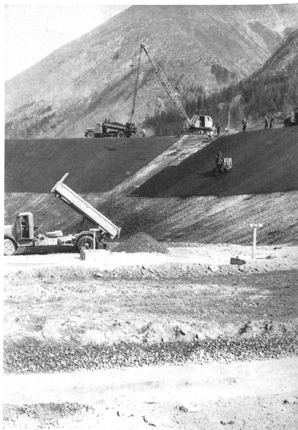
Fig. 17 Das Ausgleichbecken Zerbeiggern im Herbst 1963: Im Vordergrund Einbau des Sickerkieses über den Drainageröhren, der Filter- und der Drainageschichten; im Hintergrund Einbau der porösen Bitumenbetonschicht auf die Drainageschicht der Dammböschung.
