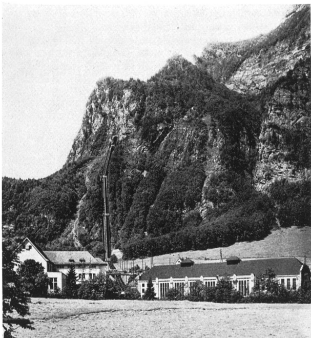
Löntschwerk, Druckleitung mit Maschinenhäusern
