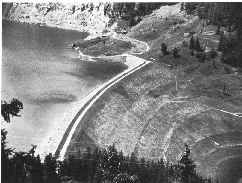
Blick auf den Erddamm Castiletto für den Stausee Marmorera im Oberhalbstein. Durch eine sinnvolle Gestaltung des Dammkörpers und zweckmässige Bepflanzung fügt sich ein Staudamm viel weicher und unauffälliger in die Landschaft als beispielsweise eine gleich hohe Betontalsperre (Photo Guler, Thusis)
