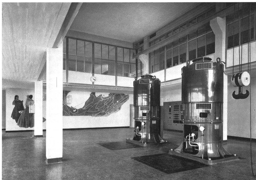
Fig. 3 Maschinensaal mit zwei 1040 PS Vertikalmotoren in der Filteranlage Lengg des Seewasserwerkes II der Stadt Zürich (Photo H. Wolf-Benders Erben, Zürich)
