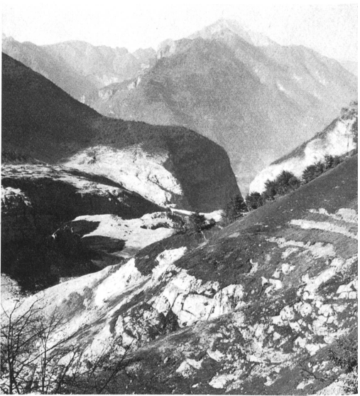
Fig. 12 Talseitige Ansicht der Bogenstaumauer nach der Katastrophe. Der Aquädukt der Druckleitung Pieve di Cadore-Soverzene (Umfahrung des Speichers Vaiont) ist weggefragt (vgl. Fig. 1).
