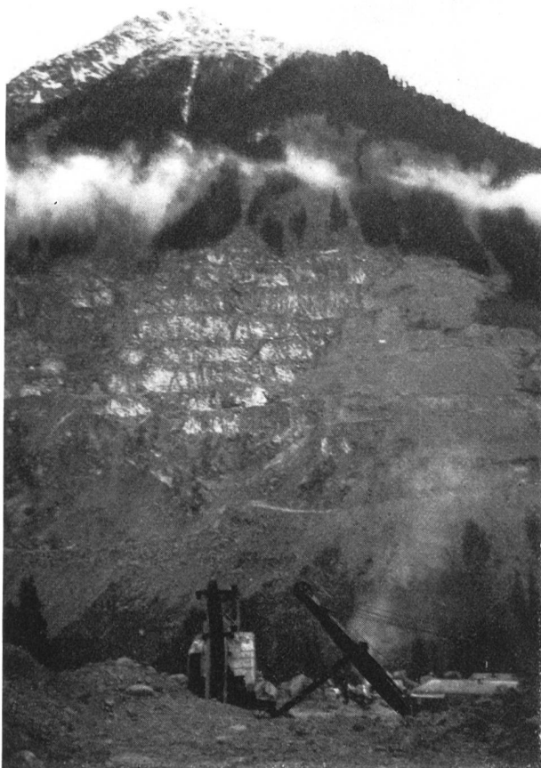
Fig. 12 Ansicht der in verschiedenen Abbruchschichten erschlossenen hohen Felswand zur Gewinnung des Stützmaterials für den Staudamm Gepatsch
