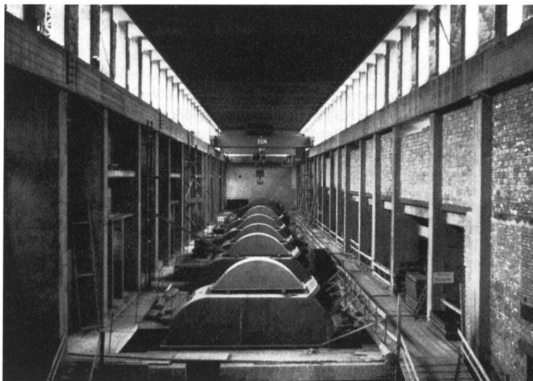
Fig. 7 Maschinenmontage in der grossen Kraftthauhalle Prutz des Kaunertal-Kraftwerks
