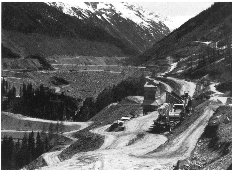
Fig. 14 Blick von der Baustelle Gepatsch taleinwärts auf den im Aufbau begriffenen Steindamm; im Vordergrund Sortier- und Trocknungs-Anlagen.
