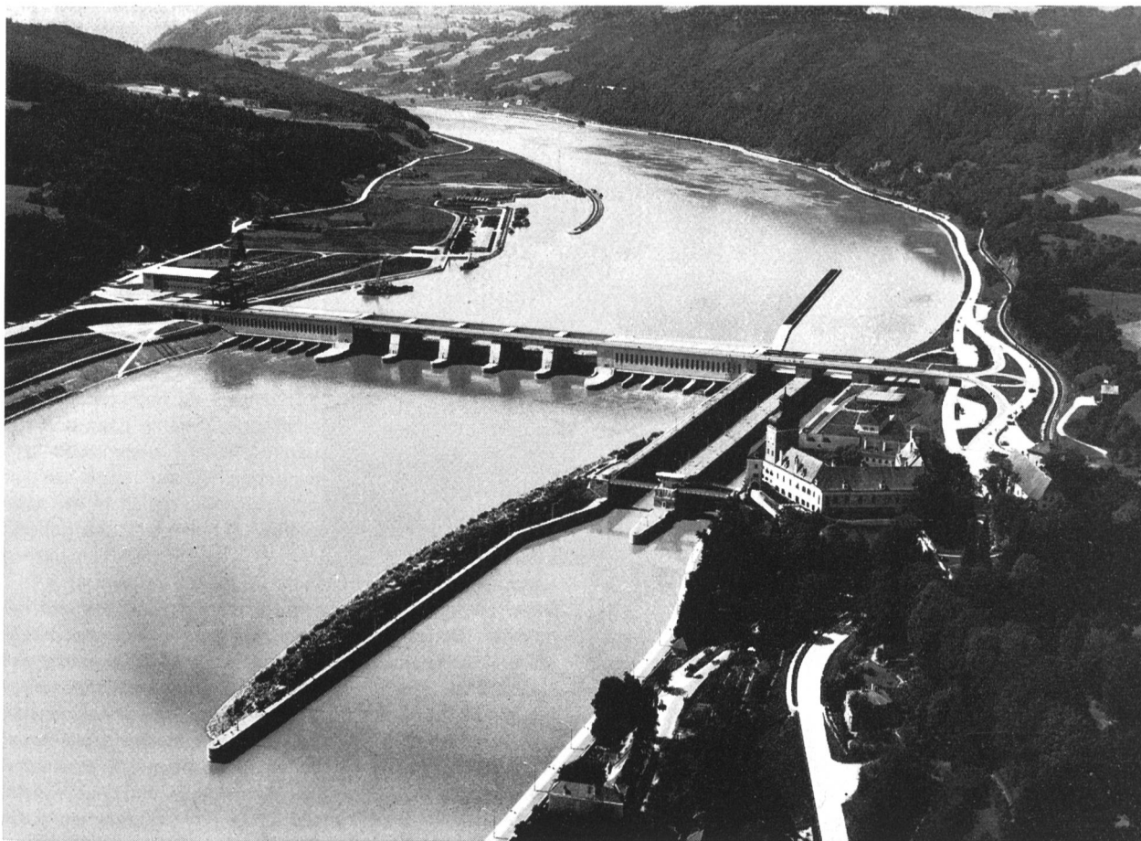
Fig. 78 Donaukraftwerk Ybbs-Persenbeug. Hier ist die betonte durchgehende Horizontale über dem Wehr und über den seitlichen Zwillings-Kraftwerken mit durchgehender Strassenüberführung als konstruktives Element zur guten Einfügung in das Landschaftsbild besonders gut sichtbar. Rechts Schiffahrtsschleuse und Schloss Persenbeug.
