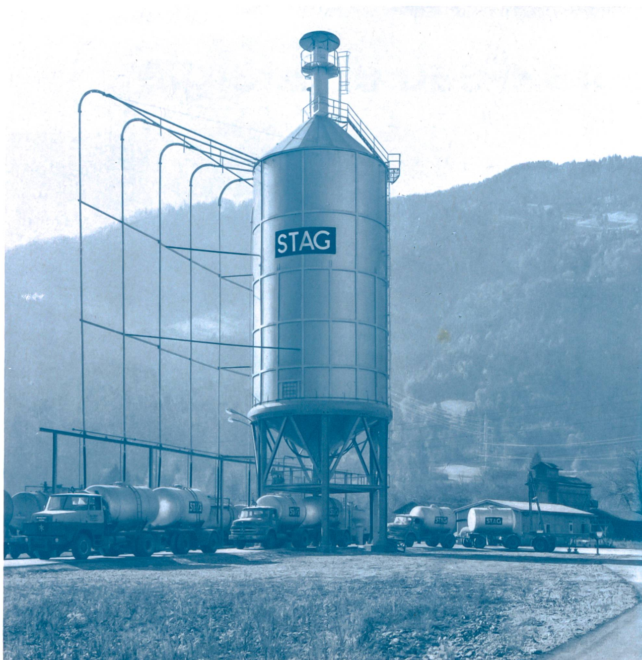
Umschlagsanlage der STAG in Vandans/Vlbg. mit Silo von 1600 t Fassungsvermögen. Zementtransporte nach der Baustelle der Staumauer Kops der Illwerke.
