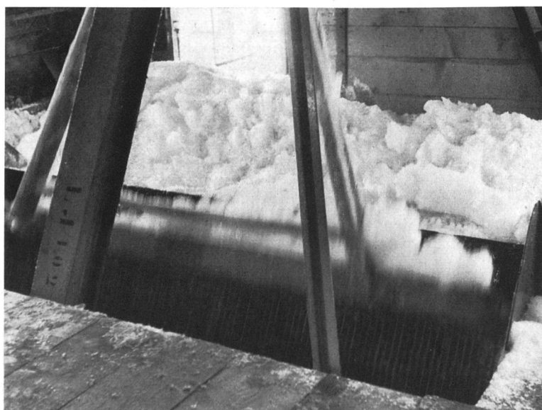
Stationäre, automatische Rechen- reinigungsmaschine bei der Arbeit bei grossem Grundeisanfall
