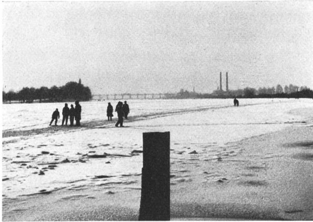
Fig. 15 Kraftwerk Wyhlen, 27. 1. 1963 Stauwehr und Kraftwerk von der Fähre Augst-Herten gesehen
