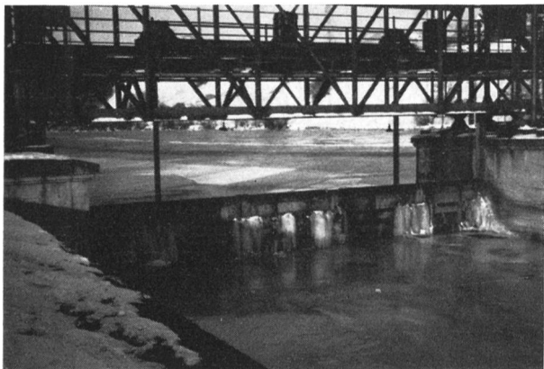
Fig. 4 Kraftwerk Bannwil: Rechenreinigungsmaschine im Einsatz, 25. 1. 1963
