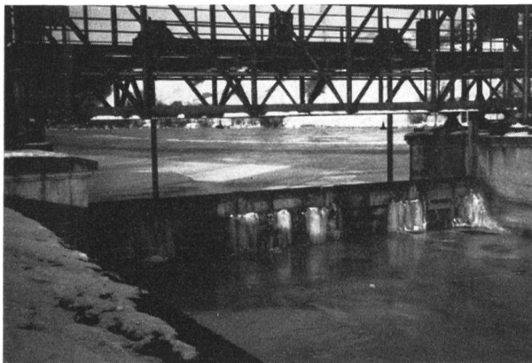
Fig. 4 Kraftwerk Bannwil: Rechenreinigungsmaschine im Einsatz, 25. 1. 1963
