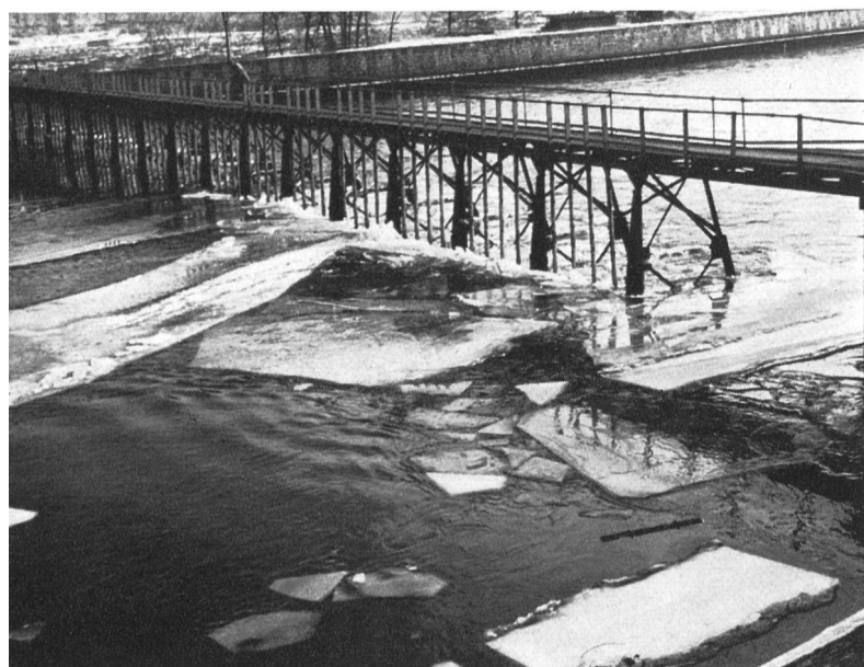
Fig. 9 Kraftwerk Rheinfelden: Platteneis am Grobrechen des Kanaleinlaufes, 10. 2. 1963
