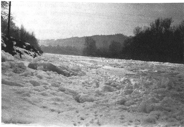
Fig. 19 Kraftwerk Eglisau: Thur unterhalb der Thurbrücke Ellikon total zugefrozen
