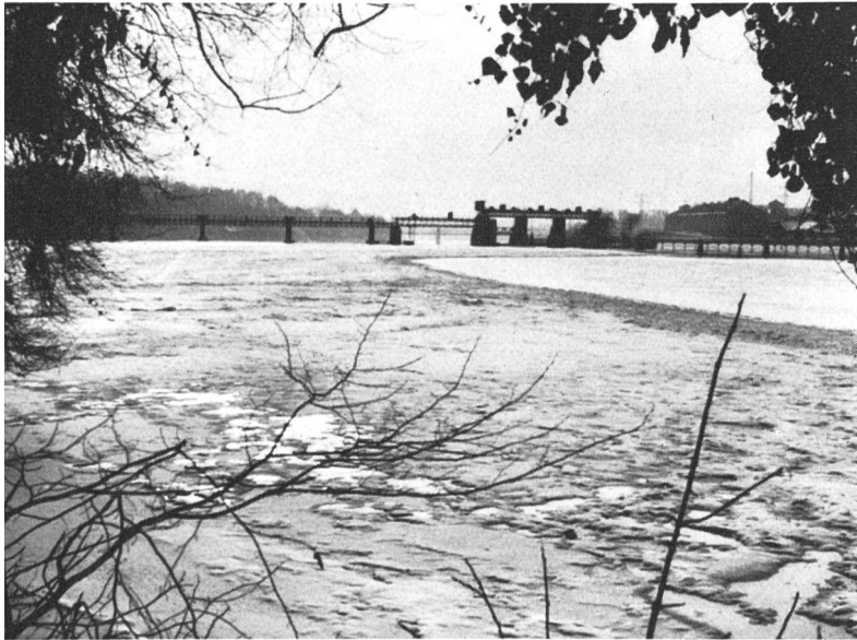
Fig. 8 Kraftwerk Rheinfelden: Wehr mit eisfreier Fließrinne zum Kanal, 28. 1. 1963
