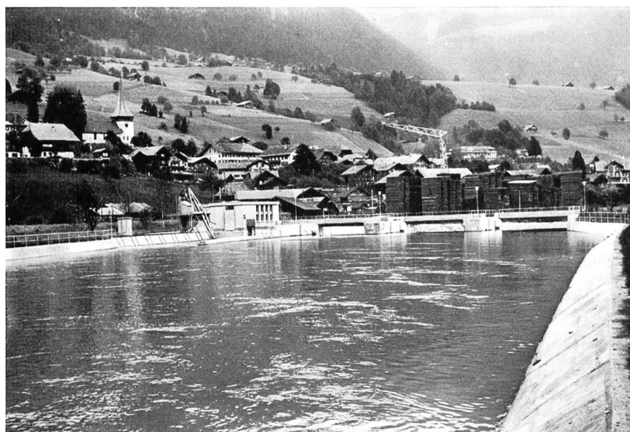
Fig. 5 Wehr Erlenbach, Blick flussabwärts. Aufnahme Sommer 1963 bei Normalstau.
