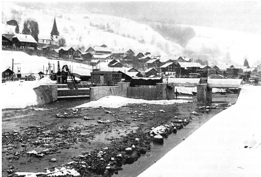
Fig. 4 Wehr Erlenbach, Blick flussabwärts. Bauzustand am 14. 3. 62, die 1. Hauptöffnung mit den Damm-balkennadeln abgeschlossen; im Hintergrund ein Teil des Dorfes Erlenbach.
