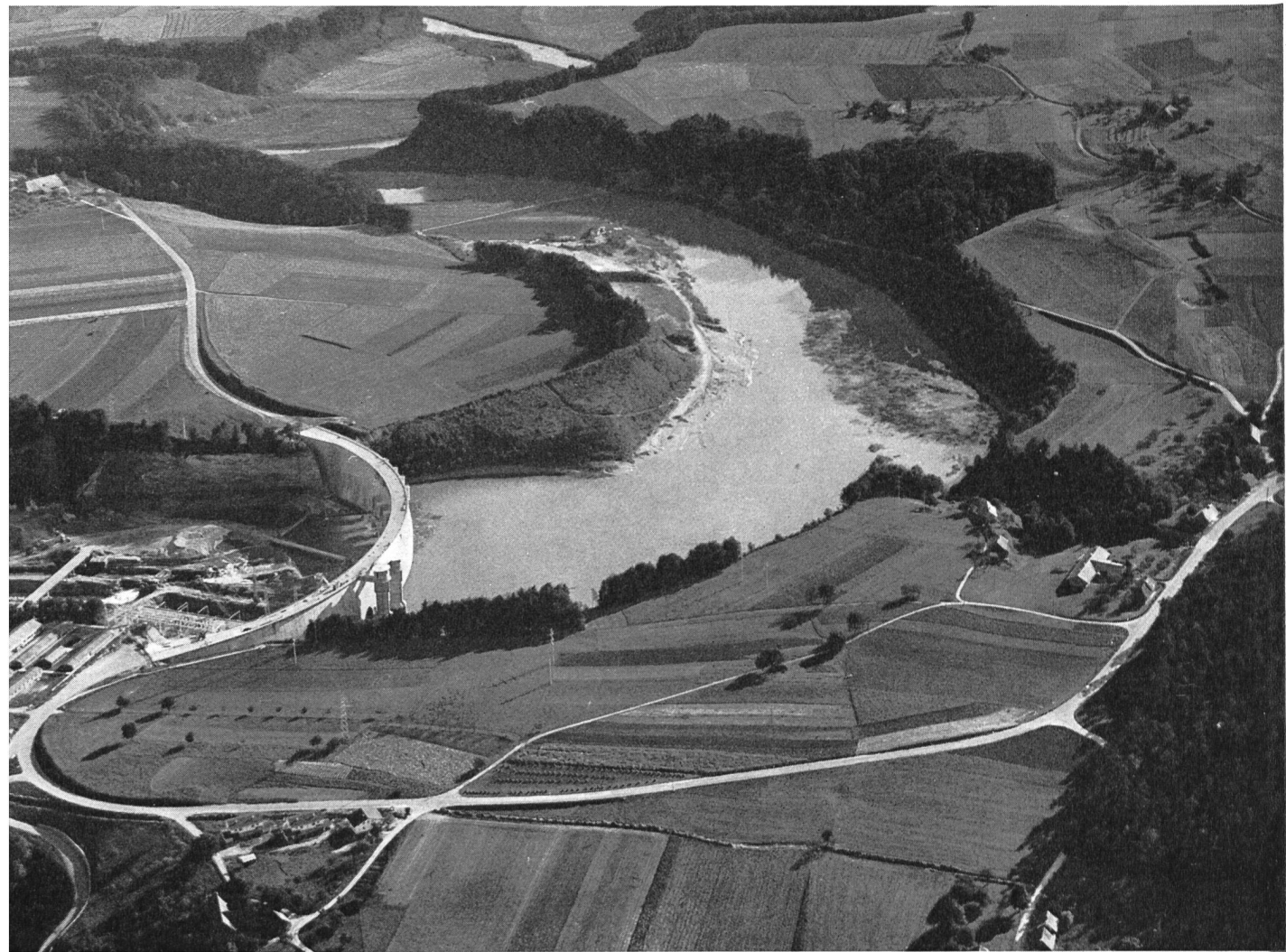
Fig. 18 Luftaufnahme der Talsperre Schiffler der Entreprises Electriques Fribourgeoises an der Saane; das Maschinenhaus steht am linksseitigen Fuss der Bogenmauer, über deren 417 m lange Krone die neue Strasse führt; der zukünftige Stausee reicht auf seiner Länge von 13,5 km bis in die Gegend der Stadt Freiburg.
