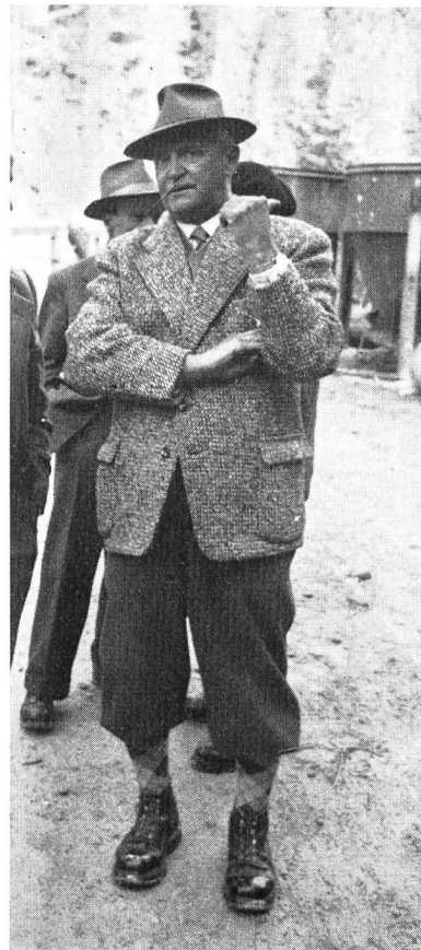
Fig. 17 Obering. Karl Zuber, örtlicher Bauleiter für die Wasserkraftanlagen auf Schweizergebiet.
