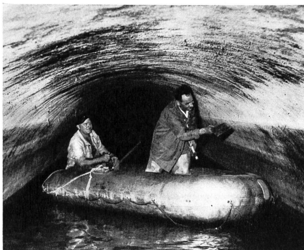
Fig. 2 Travaux d'entretien dans un égout moderne, sections 2,80/2,20 m
