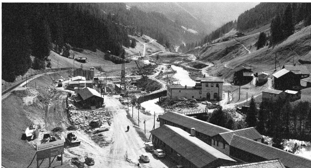
Fig. 8 Baustelle der Wasserfassung, des Ausgleichbeckens und des Landwasserkanals im Raum Glaris-Ardüs
