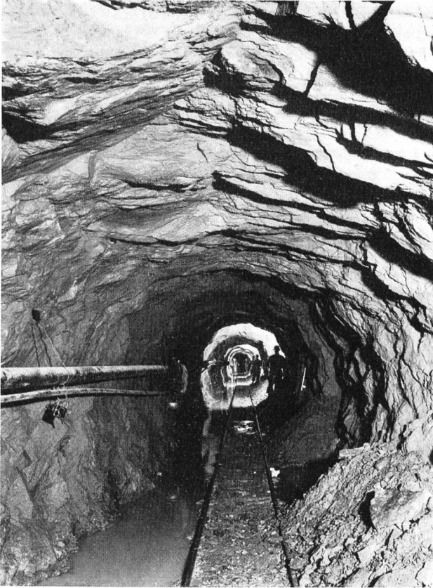
Fig. 10 Galerie d'amenée, entre les Toules et Brettmort.
