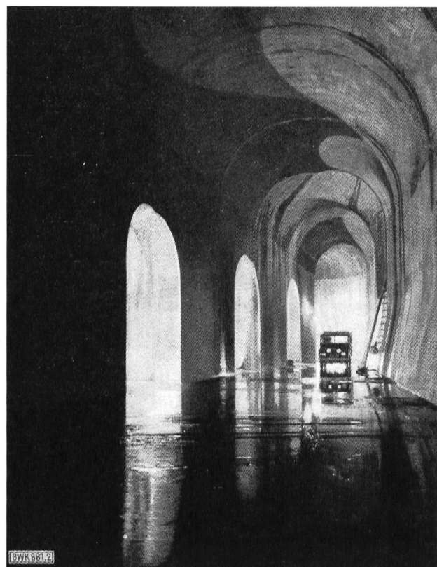
Fig. 13 Beruhigungskammer im Ablaufstollen des Kavernenkraftwerkes Tumut 1
