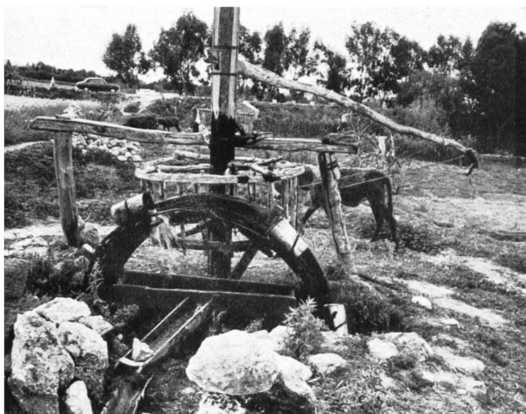
Fig. 43 Esel mit primitiver Noria im Gebiete von Azemmour am Atlantik. Mit verbundenen Augen trotten diese Zugtiere stundenlang im Kreise, um das wenige köstliche Naß in die kleinen Bewässerungs- rinnen zu heben Ane faisant tourner une noria primitive près d'Azemmour, au bord de l'Atlantique Yeux bandés, ces animaux tournent en rond pendant des heures pour élever l'eau précieuse dans les petites rigoles d'irrigation
