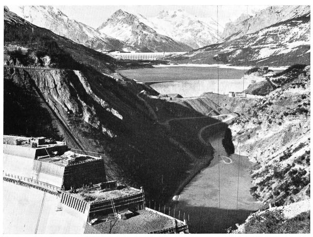
Fig. 7 Barrages de San Giacomo (type Nœtzli), Cancano I (voûte) et Cancano II (poids-voûte)
