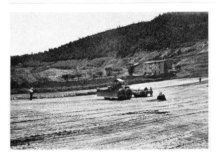
Bild 19 Talsperre Corbara, Erddamm-Verdichtung
