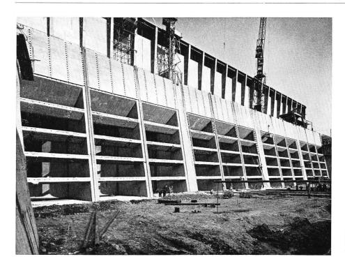
Fig. 15 Usine d'Isola Serafini; entrée des chambres des turbines
