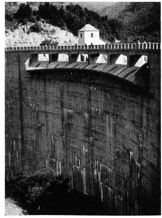
Bild 3 Bogenstaumauer Provvidenza, Luftseite mit Hochwasser-Überfall
