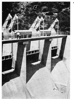
Bild 12 Automatische Klappen der Hochwasserentlastung
