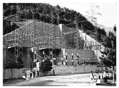
Bild 4 Kavernenzentrale Provvidenza, Eingang mit Freiluft-Schaltanlage
