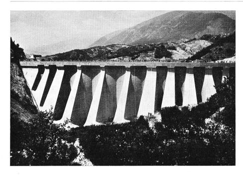
Bild 2 Talseitige Ansicht der Pfeilerkopfmauer Casoli
