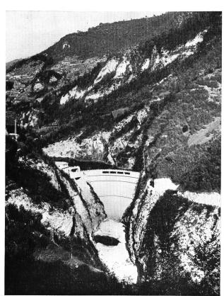
Bild 7 Bogensperre Corlo am Torrente Cismon
