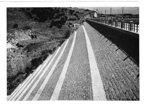
Bild 24 Steindamm Cuga, luftseitige Ansicht
