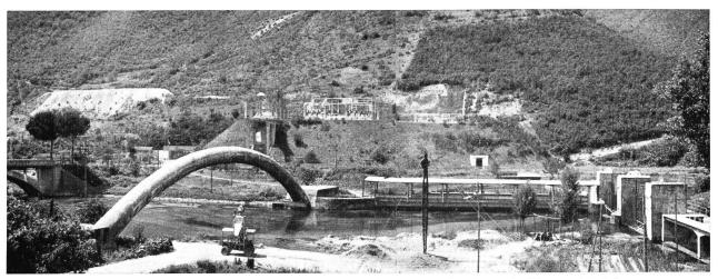
Bild 1 Zentrale Cotilia, im Vordergrund Düker über den Velino-Fluß und Wasserfassung, im Hintergrund Freiluft-Schaltanlage auf künstlich geschüttetem Hügel, in welchem sich die Kavernenzentrale befindet
