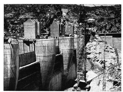
Bild 28 Bogenstaumauer Gusana, seitliche Hochwasserentlastung von der Wasserseite
