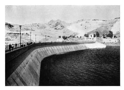
Bild 30 Wasserseitige Teilansicht der Talsperre Pozzillo mit den abdichtenden Eisenblechtafeln
